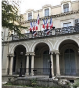
Immeuble du 3 Boulevard Henri IV, devenu siège de la Délégation Militaire Départementale de l'Hérault.
